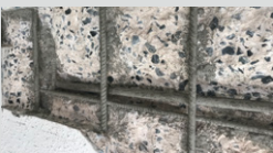
Protección de Varillas Contra Corrosión
