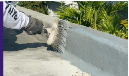
Finalice aplicando la mezcla en el techo con un cepillo de cerdas finas de 24" a un espesor de 1/32" - 1/8".
