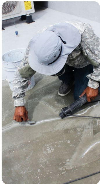
Limpieza con blower o compresor
