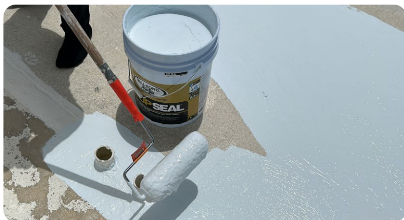
Aplicación de sellador en penetraciones.
