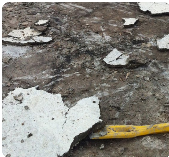
Lavado de Agua a Presión >3,000 PSI
