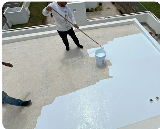
Aplicación de primera capa
