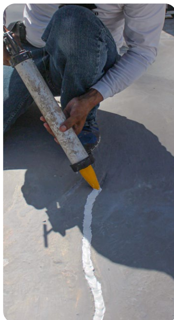
Aplicar sellante dentro del corte
