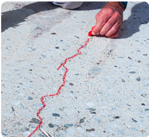
Identificar grietas >20 mils y marcar
