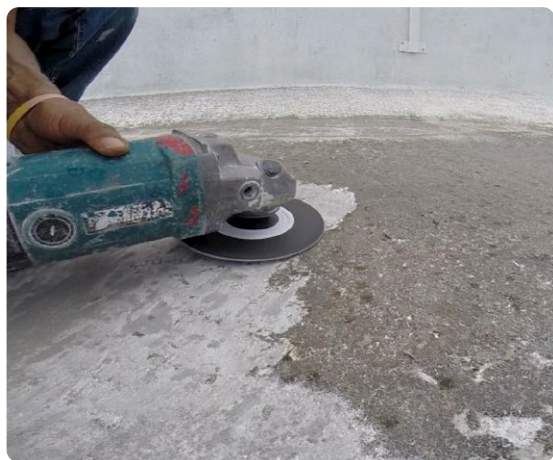
Remoción de sellador expirado con Disco Zec
