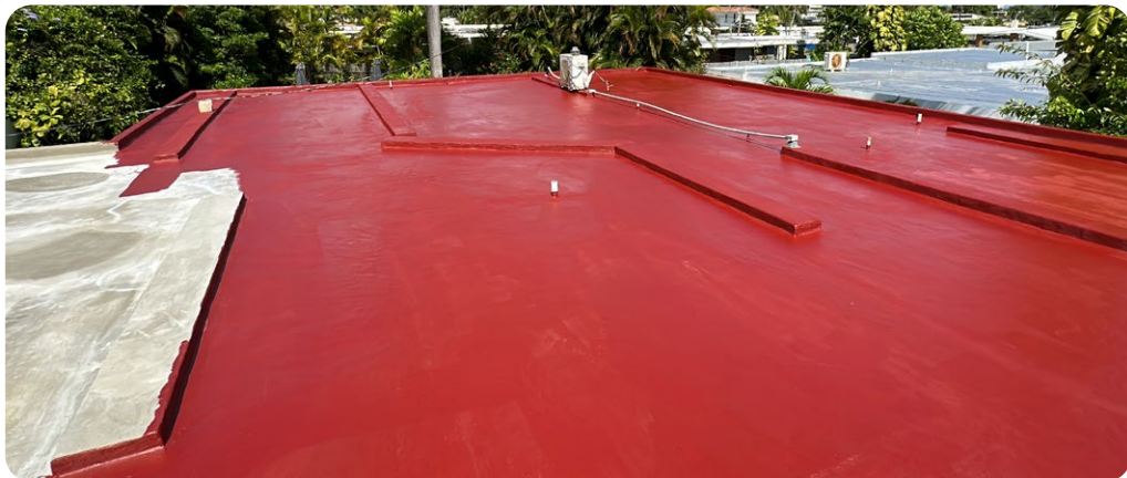
Aplicación de Primer (Pro-Sil® Primer) previo al sellador.
