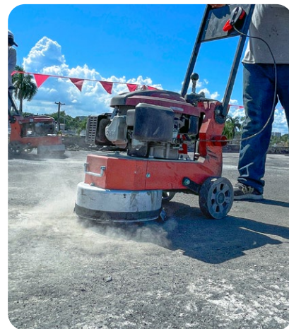
Preparación de superficie con devastadora
