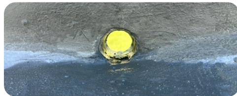
Reparación de drenajes (mezcla de Sabakrete™ y General Repair)
