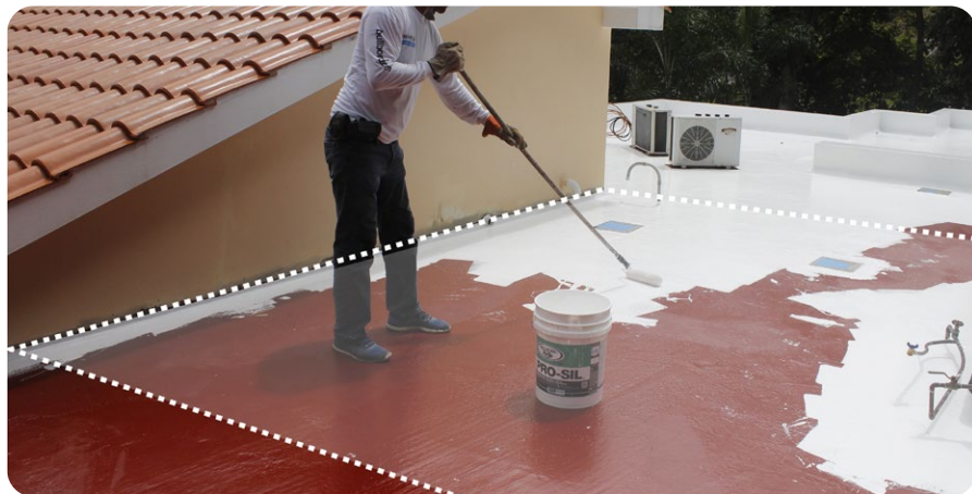
Cuadrícula el techo en secciones equivalentes a 1 capa de 1 paila - 325pc
