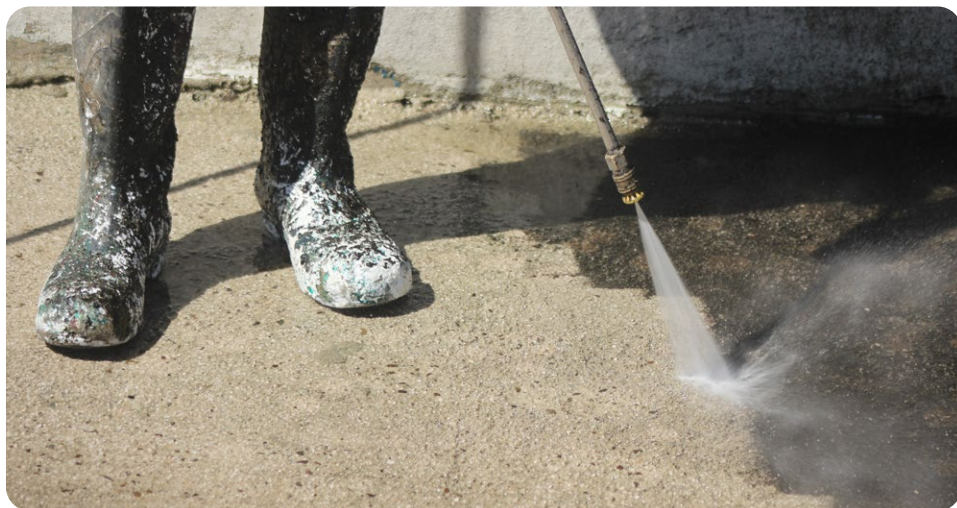
Lavado de Agua a Presión >3,000 PSI
