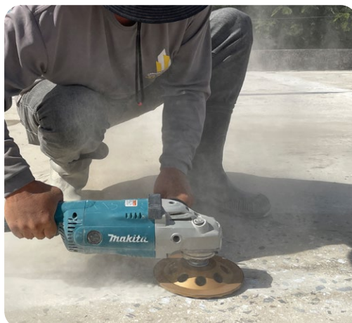
Remoción de brea con disco de desgaste
