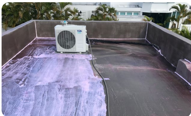
Primer cuando esta curando cambia de color a rosado a rojo y se siente pegajoso al tacto
