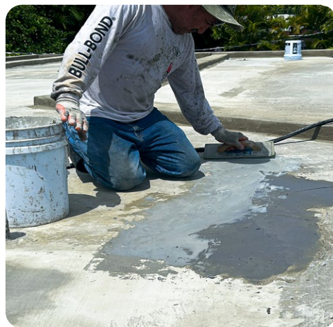
Alizado de mezcla con flota
